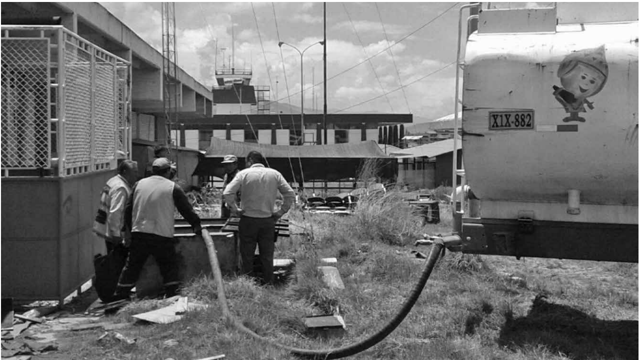
Panorama: El servicio de agua potable a la ciudad del Cusco está marcado por problemas de desabastecimiento, mala calidad del suministro, trámites burocráticos y deterioro de las fuentes hídricas.
