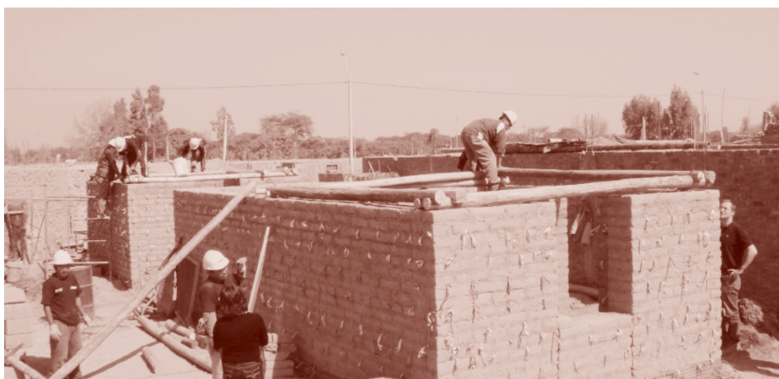
Ica: reconstrucción de una vivienda sismorresistente con geomalla.
