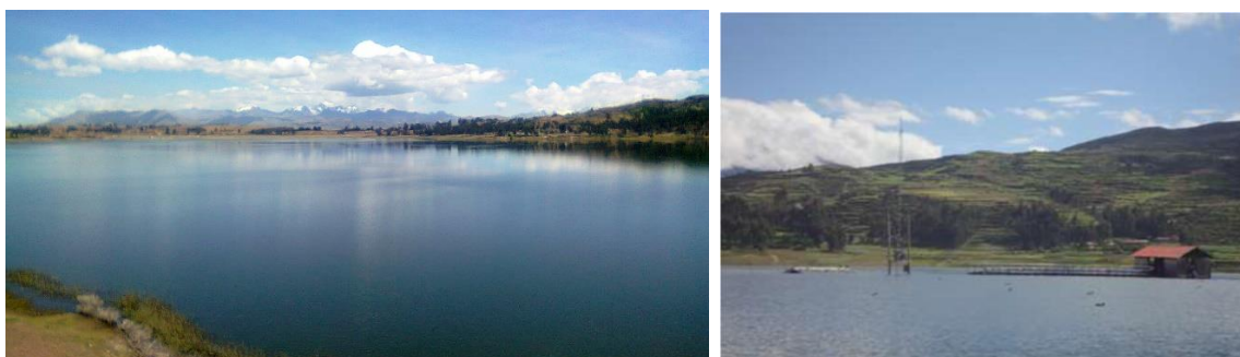
Figura 7: Captación en laguna de Piuray
