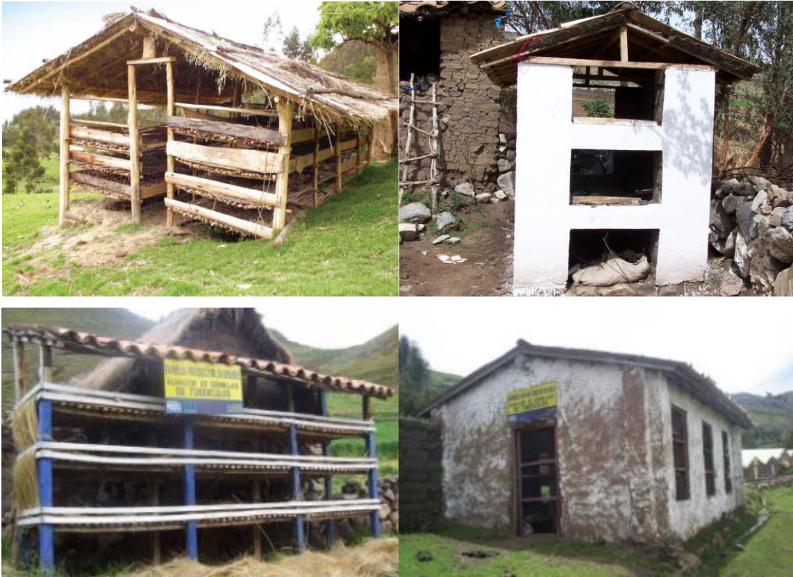
Foto 5: Diversos diseños de almacenes de luz difusa para la conservación de la semilla de papa.
