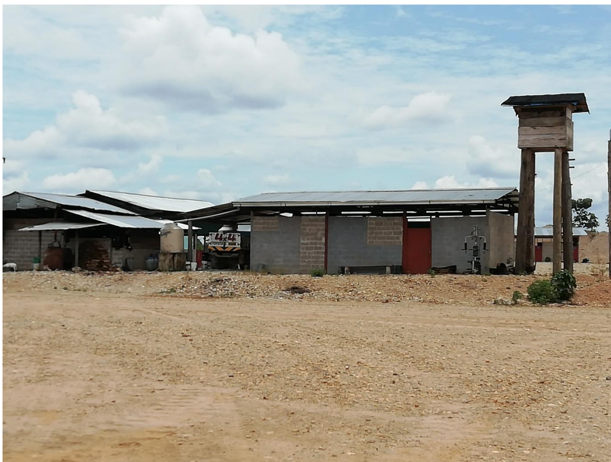
Fotografía 1: Campamento de patrón minero en el río Pukiri, dentro del territorio de la Comunidad San José de Karene
